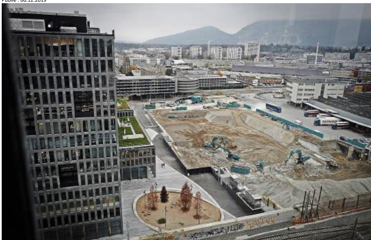
Les premières tours sont à peine achevées que les engins de chantier s'attaquent à d'autres constructions. LAURENT GUIRAUD
