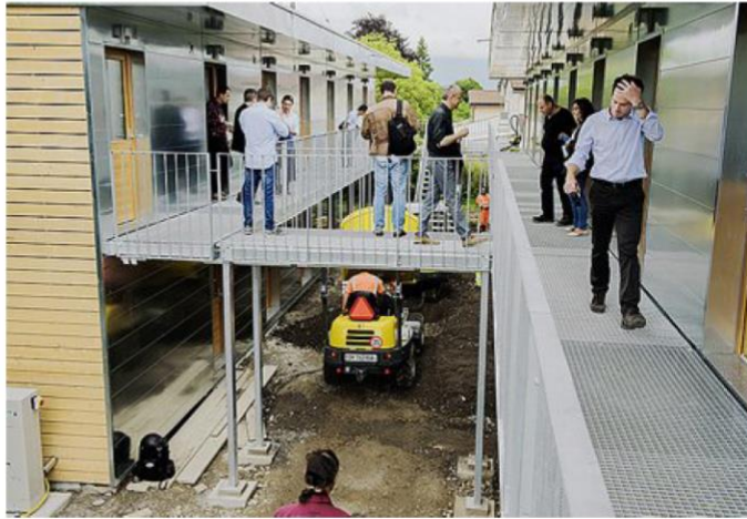
Le bâtiment est constitué de trente modules autonomes, disposés les uns à côté des autres et empilés sur deux étages. PIERRE ABENSUR
